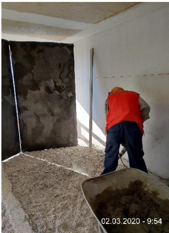
Fotografía 3. Instalación de paneles acústicos en zonas generadoras de ruido , como maquinarias , motores , generadores entre otros.
