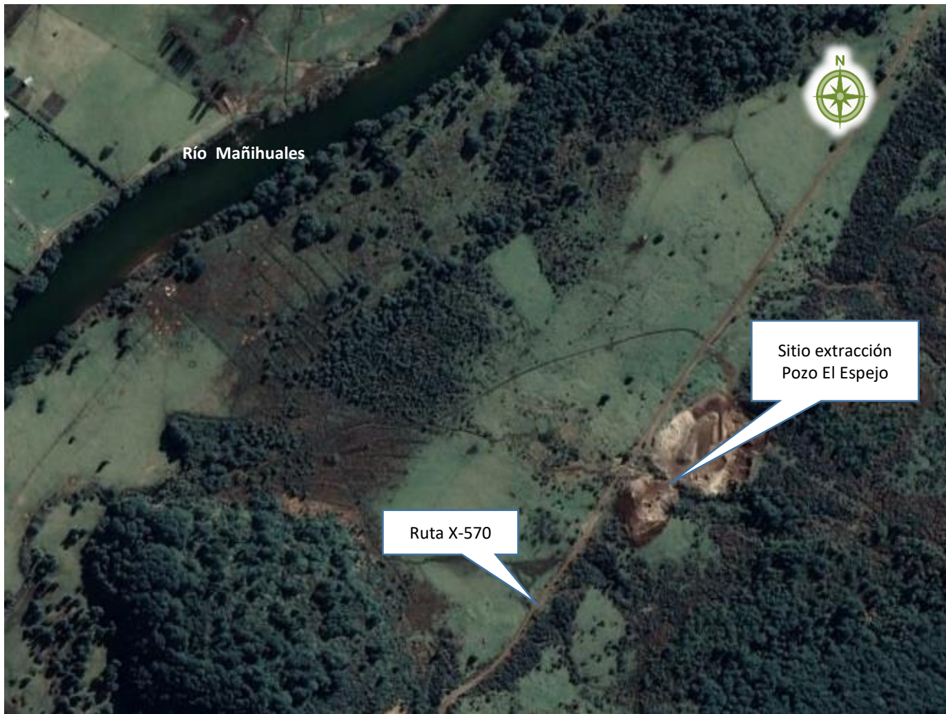
Figura 2. Layout del proyecto (Fuente: Elaboración propia en base a imagen de Google Earth Pro).
