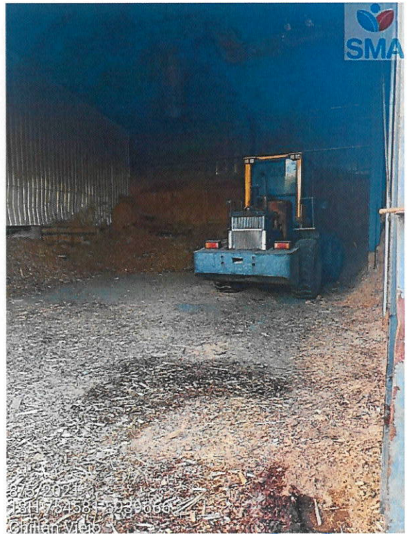
Galpón de combustible biomasa sin stock
