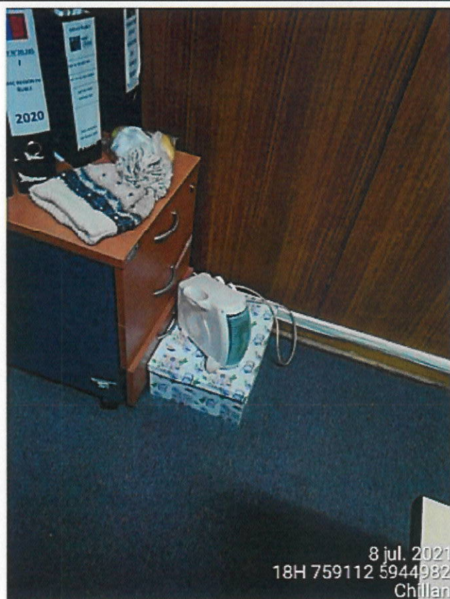
Equipo eléctrico de calefacción.
