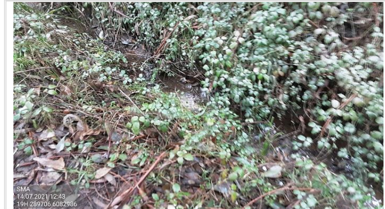
Fotografía 2. Canal Evacuador de Aguas Lluvia (Sitio 1 del Plantel)
