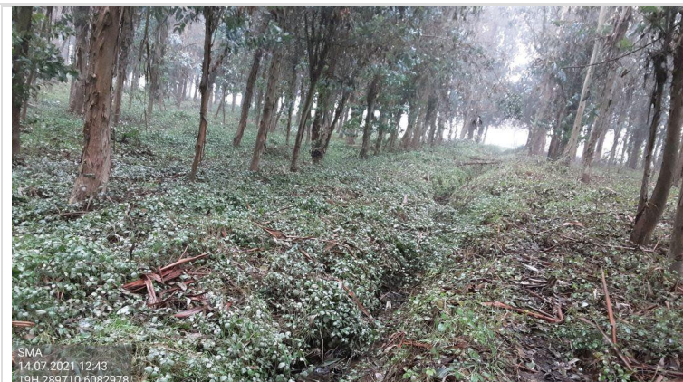
Fotografía 3. Canal evacuador de aguas lluvia (Sitio 1 del Plantel).
