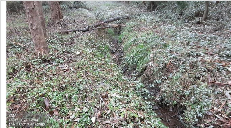
Fotografía 1. Canal evacuador de aguas lluvia (Sitio 1 del Plantel).
