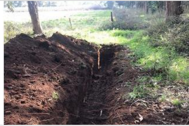
Fotografía 10. Fotografía de corta foso implementado en la zona de riego con purín por el titular, remitida en presentación de fecha 03 de septiembre de 2021.
