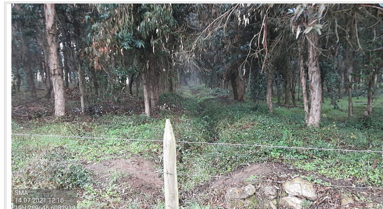
Fotografía 4. Vista del canal evacuador de aguas (Vista desde camino vecinal)
