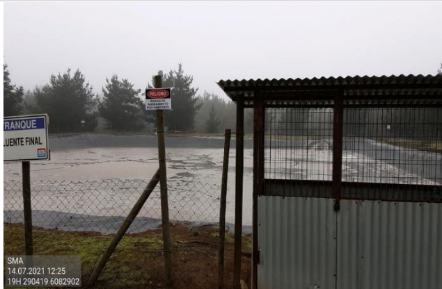
Fotografía 5. Tranque de acumulación de purines en el denominado Sector 1 del Plantel de Cerdos Agrícola Chorombo.
