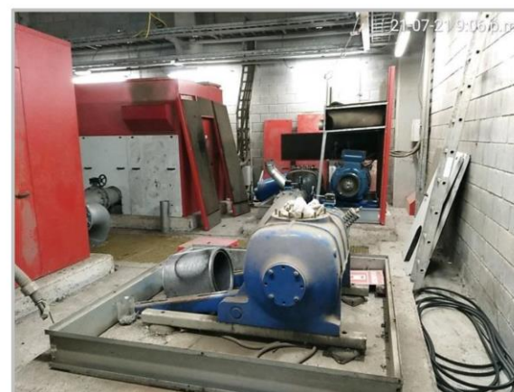
Figura 6 y 7. Fuentes de ruido presentes en la planta (caudal y sopladora).
