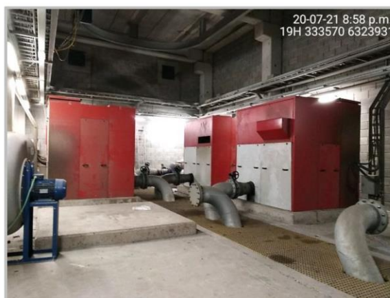
Figura 6 y 7. Fuentes de ruido presentes en la planta (caudal y sopladora).
