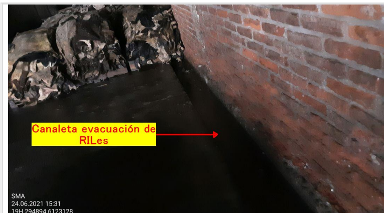
Fotografía 10. Sistema de captación de RILes en el saladero, correspondiente a una canaleta hormigonada. Desde esta canaleta se remiten al sistema conductor de aguas lluvia, pasando por la bodega de insumos.
