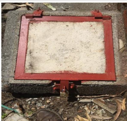
Fotografía 13. Fotografía de la cámara de inspección 1 reparada y reforzada con marco metálico con pomeles y candado de seguridad.
