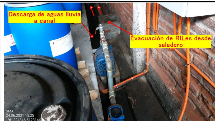
Fotografía 4. Sector donde se ubica el canal evacuador de RILes provenientes del sector saladero de descarga de aguas lluvias proveniente del patio.
