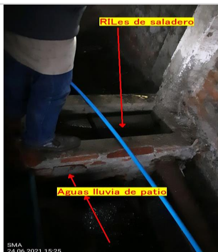
Fotografía 5. Fotografía de la zona donde se emplaza la conducción de RILes desde saladero hacia el sector de bodega de insumos. También se observa la descarga de aguas lluvia hacia canal.
