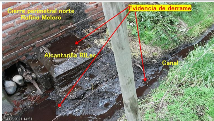
Fotografía 1. Fotografía de la alcantarilla de RIL donde se constató evidencia de derrame de RILes. Se puede apreciar la alcantarilla y el canal donde se evidencia vertido de RIL asociado al evento.
