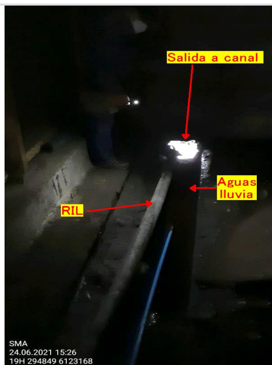
Fotografía 7. Fotografía captada dentro de la bodega de insumos, donde se aprecia la salida de RILes hacia la cámara del sistema evacuador de RILes y la salida de aguas lluvia proveniente de patios.
