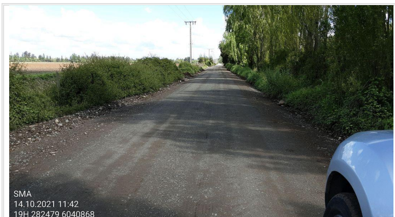
Fotografía 3. Fotografía del estado del camino Santa Ester al momento de la inspección.
