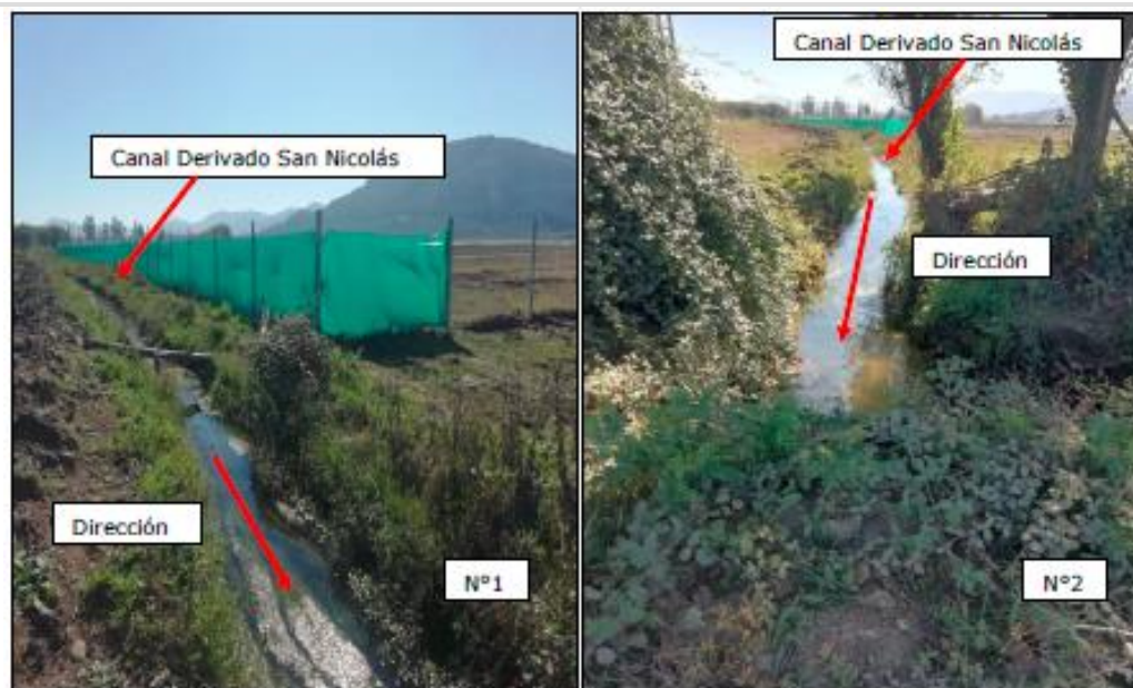
Fotografía N°1 y N°2: Canal derivado San Nicolás, con escurrimiento normal. Vista de sur a norte
