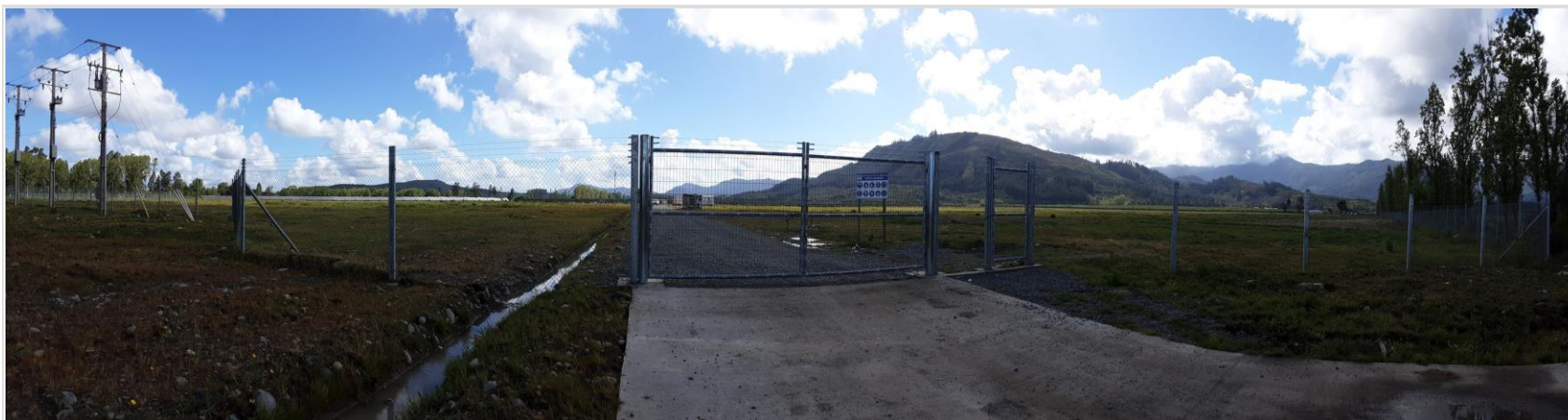
Fotografía 6. Fotografía panorámica del acceso principal a la unidad fiscalizable captada al momento de la inspección.
