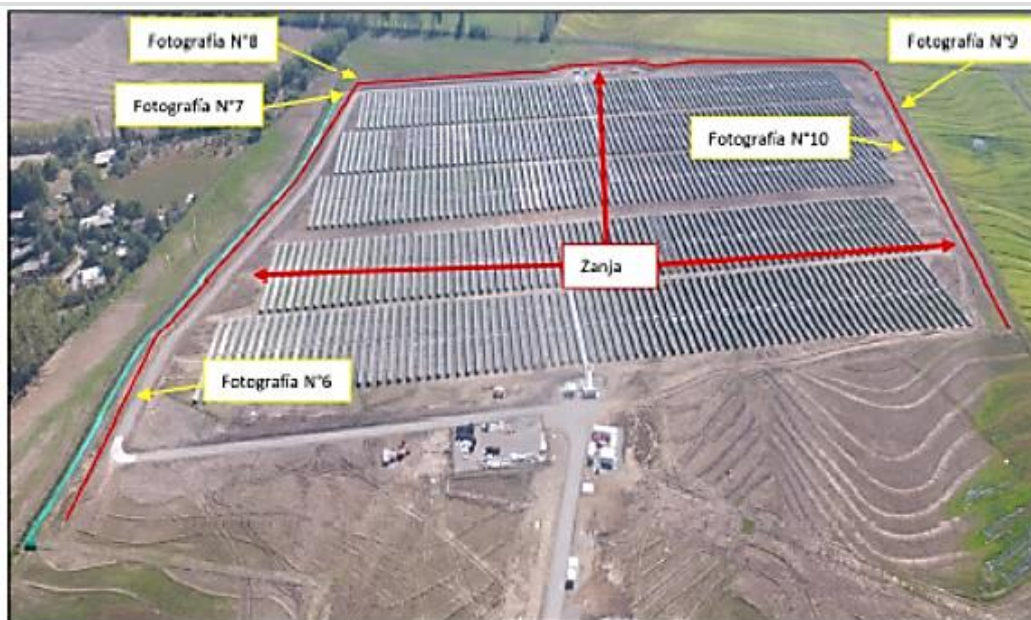
Fotografía 7. Fotografía aérea contenida en el ITF DGA N.º 26/2021, donde se indican el recorrido de inspección y algunos de los puntos donde se realizó capturas fotográficas de los puntos de interés.
