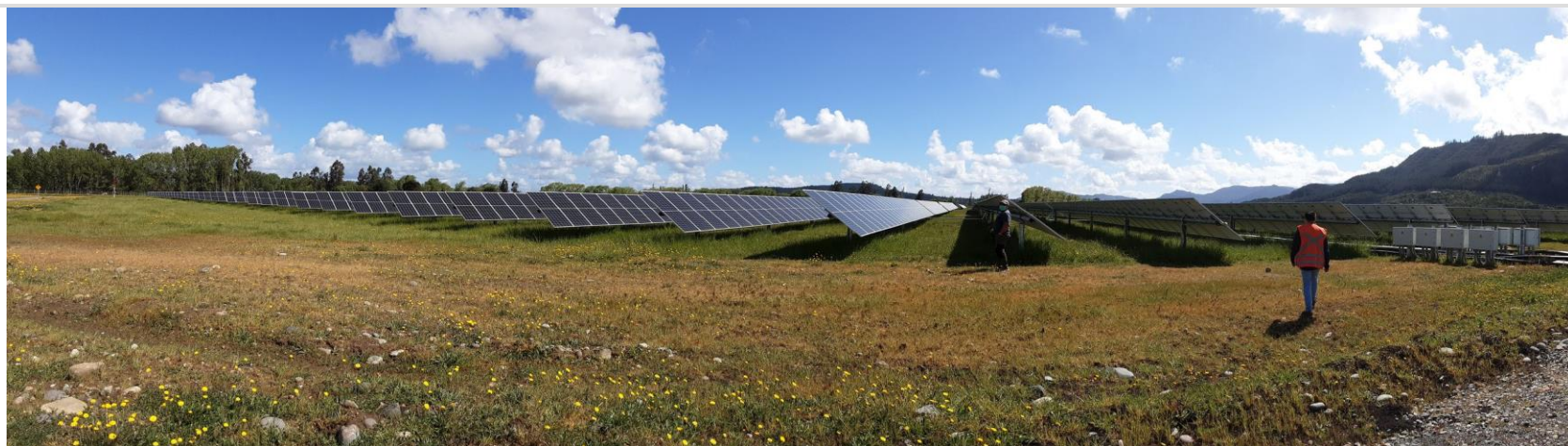
Fotografía 5. Fotografía panorámica captada al interior de la unidad fiscalizable.
