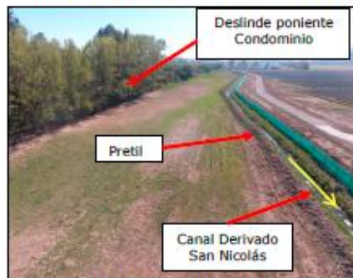
Fotografía N°3. Canal y pretil lado poniente. vista de sur a norte.
