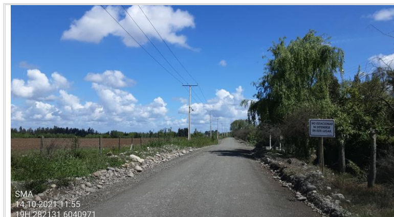
Fotografía 2. Fotografía del estado del camino Santa Ester al momento de la inspección
