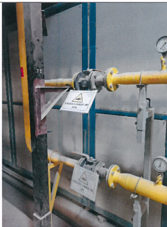
Fotografía 2. Alimentación de horno de secado de piezas. Se aprecia utilización de GLP como combustible al momento de la inspección.
