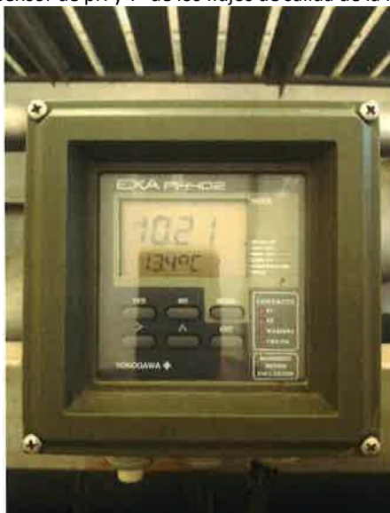
Figura 3. Sensor de pH y T° de los flujos de salida de la Planta DAF.
