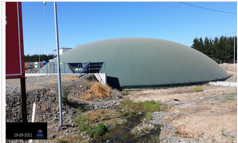
Fotografía 1. Fotografía del equipo biodigestor captada durante la actividad de inspección.
