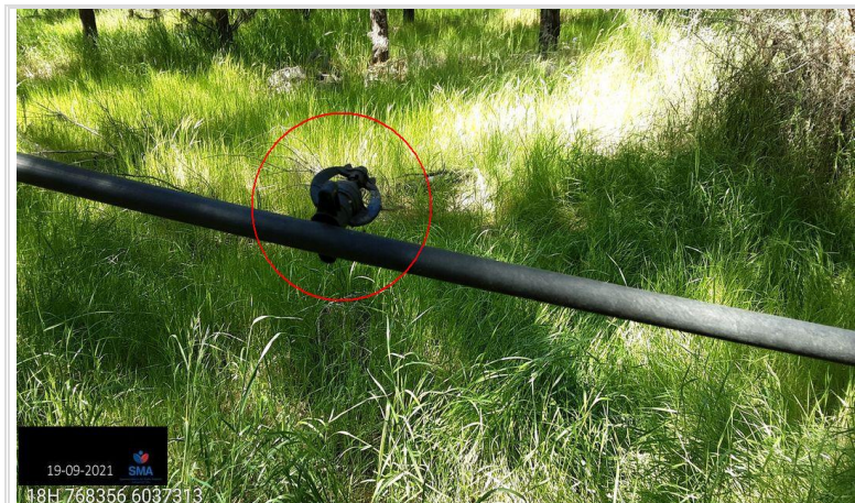
Fotografía 16. Fotografía de uno de los aspersores de la línea de riego.
