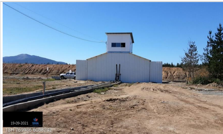
Fotografía 5. Fotografía del edificio donde se emplaza la unidad de separación de fases del digestato generado en el biodigestor (sólido - líquido).
