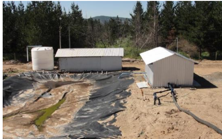
Fotografía 9. Fotografía de la caseta de riego al momento de la inspección.
