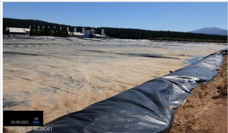
Fotografía 7. Fotografía de la laguna de acumulación de digestato líquido. Se observa que se encuentra con una cobertura superficial de HDPE.
