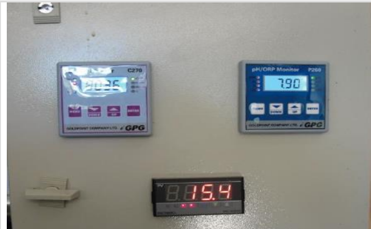
Fotografía 13. Pantalla de monitoreo de calidad de riego: el punto de medición se localiza posterior a la mezcla de digestato con agua.
