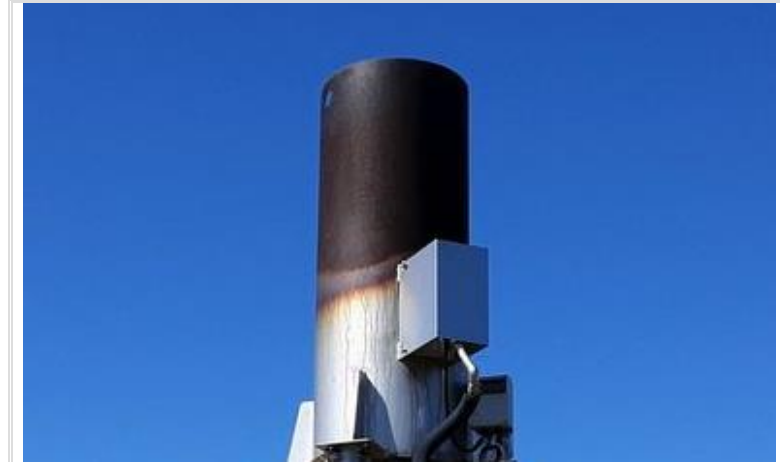
Fotografía 4. Fotografía en primer plano de la antorcha captada al momento de la inspección, la cual se encontraba apagada.
