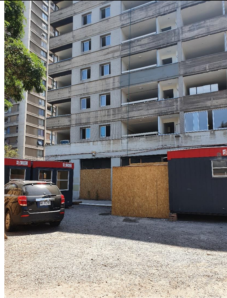
Figura 4. Vista faena constructiva. – Fuente: inspección en terreno 23/12/2021.
