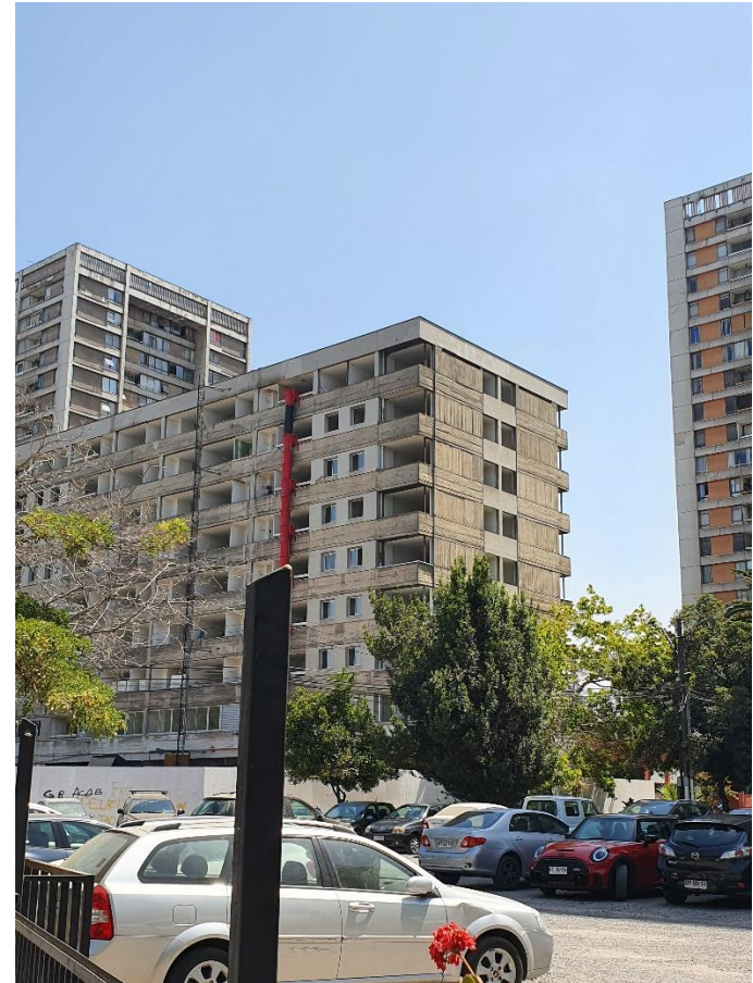
Figura 2. Vista general faena constructiva. – Fuente: inspección en terreno 23/12/2021
