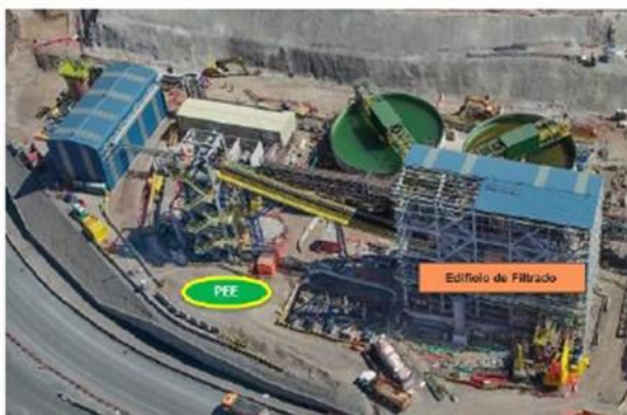
PEE Sector descarga y despacho de concentrado
