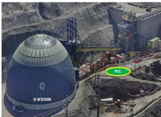
PEE Sector Acopio y Chancado PTE
