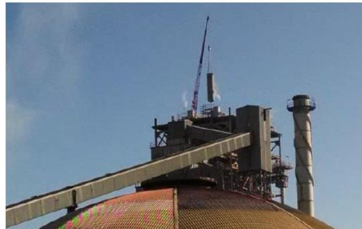
Figura 8. Vista de maniobra reemplazo silenciador ciclón caldera poder
