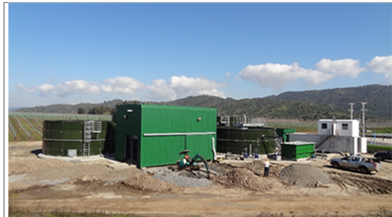
Fotografía 8. Fotografía aérea de la planta de tratamiento de RILes de la unidad fiscalizable, con las modificaciones efectuadas por el titular.
