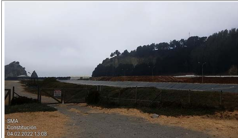
Fotografía 1. Fotografía de la Laguna de Emergencia, vacía al momento de la inspección.
