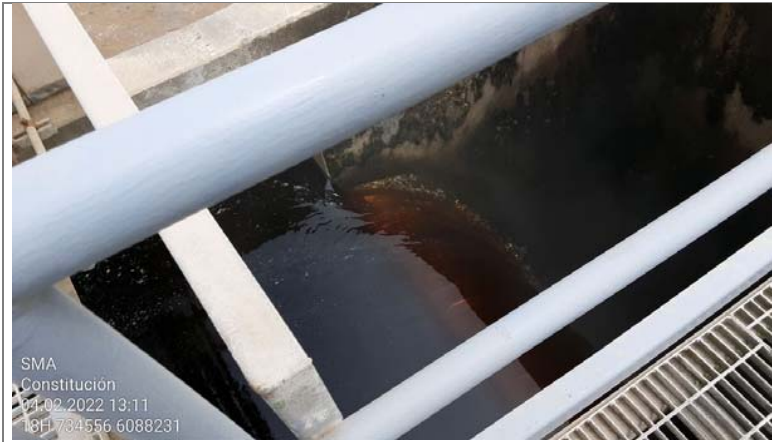
Fotografía 5. Fotografía del RIL tratado saliendo del clarificador secundario, última etapa del proceso.
