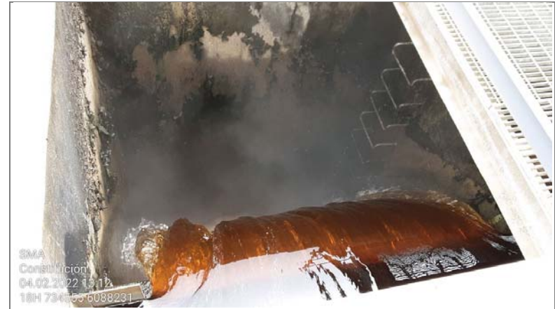
Fotografía 6. Fotografía del RIL tratado saliendo del clarificador secundario, última etapa del proceso.
