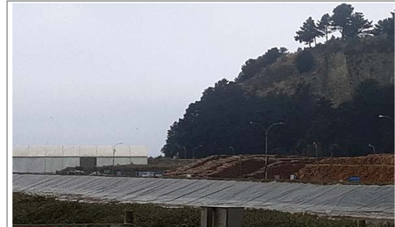
Fotografía 2. Fotografía de la Laguna de Emergencia, vacía al momento de la inspección.
