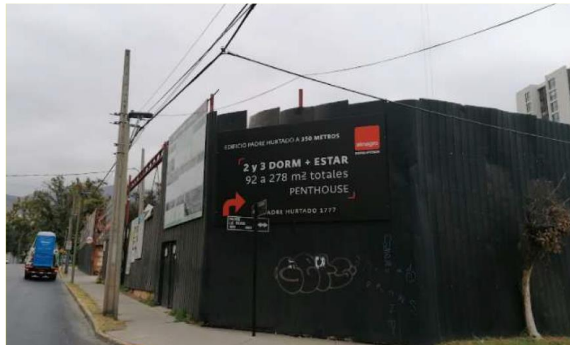
Figura 2. Cierre acústico perimetral.
