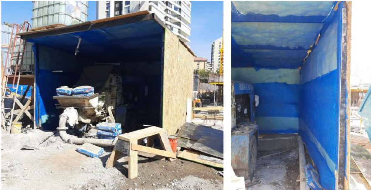
Figura 3. Encierro a bomba de hormigón.
