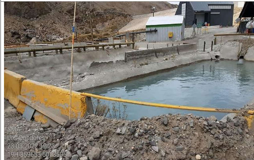
Fotografía 3. Fotografía de piscina de decantación C.
