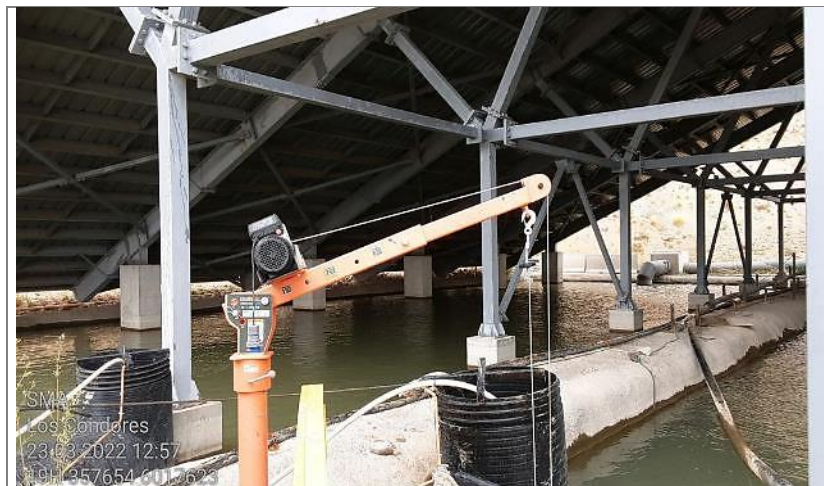
Fotografía 9. Piscinas de decantación correspondientes a los módulos A y B, operativos al momento de la inspección.
