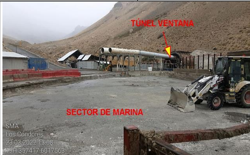
Fotografía 10. Fotografía del sector donde se ubicaba La Marina.
