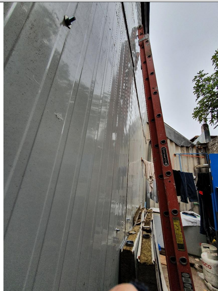
Figura 2. Muro perimetral acústico.
