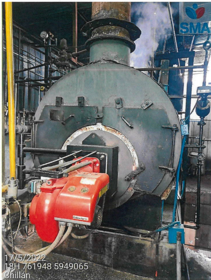
Foto 1 – Quemador a gas de uso exclusivo
