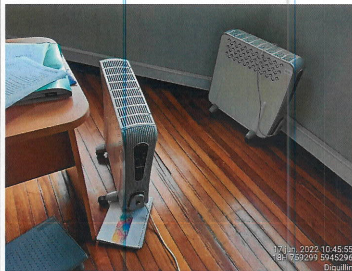
Equipo eléctrico (segundo equipo no contabilizado por estar en desuso por deperfecto).
