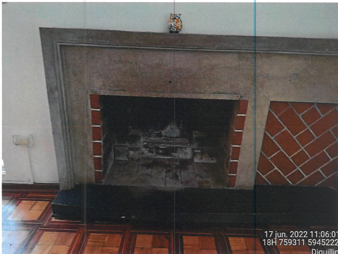
Chimenea en desuso
