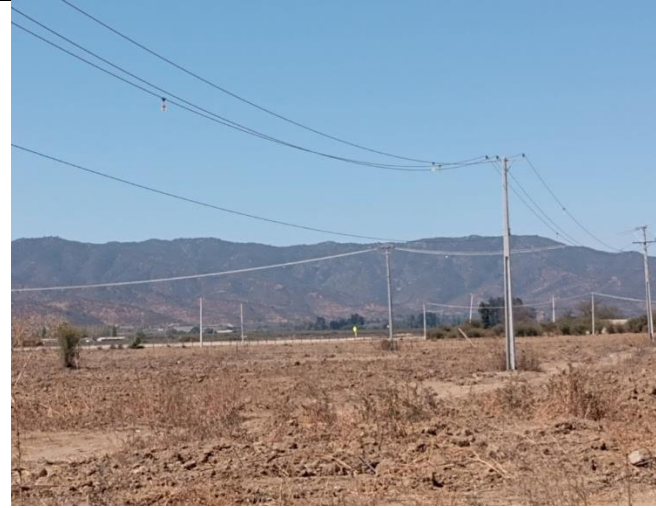
Fotografía N°4: disuadores de aves dispuestos en los torres de mediana tensión
