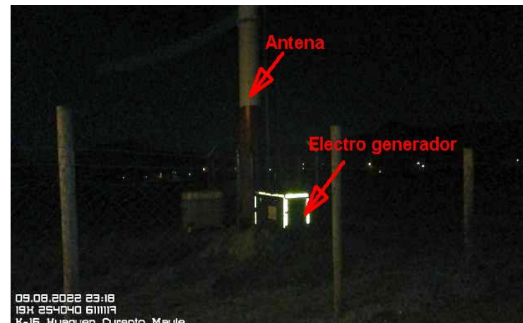
Fotografía 4. Fotografía de la unidad fiscalizable captada el día 09-08-2022, al momento que el electro generador se encontraba operando.
