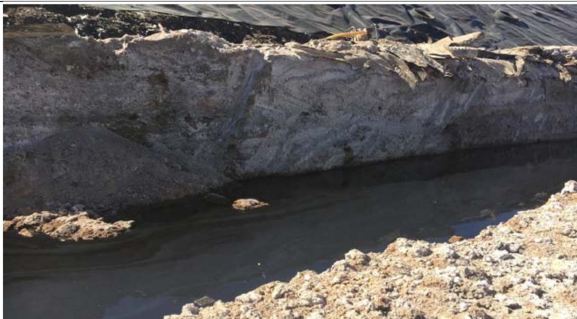
Fotografía 12: Vista de Foto del proceso investigacion BIDEMA año 2018, ausencia de lámina basal sur.
