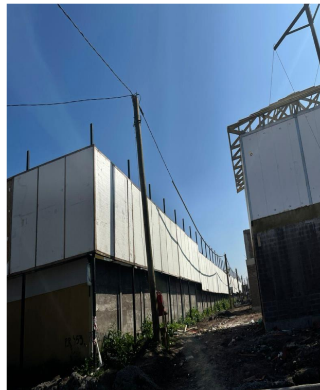
Figura 4. Cierre perimetral con aislamiento.
