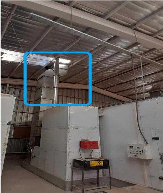
**Fotografía N°1:** Actividad de inspección 03-05-2022. Ducto de evaluación de gases de cabina de pintura y secado PR-16871. En marco azul se resalta el codo ubicado corriente abajo en la distancia B.
