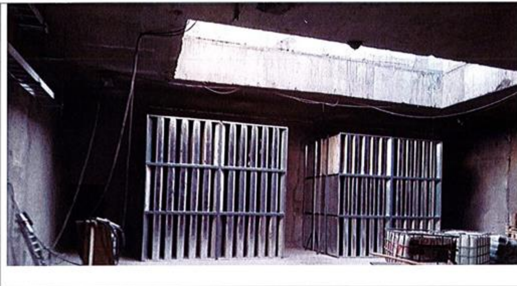
Figura 1 Ejemplo de los silenciadores rectangulares instalados en las Ventilaciones.
