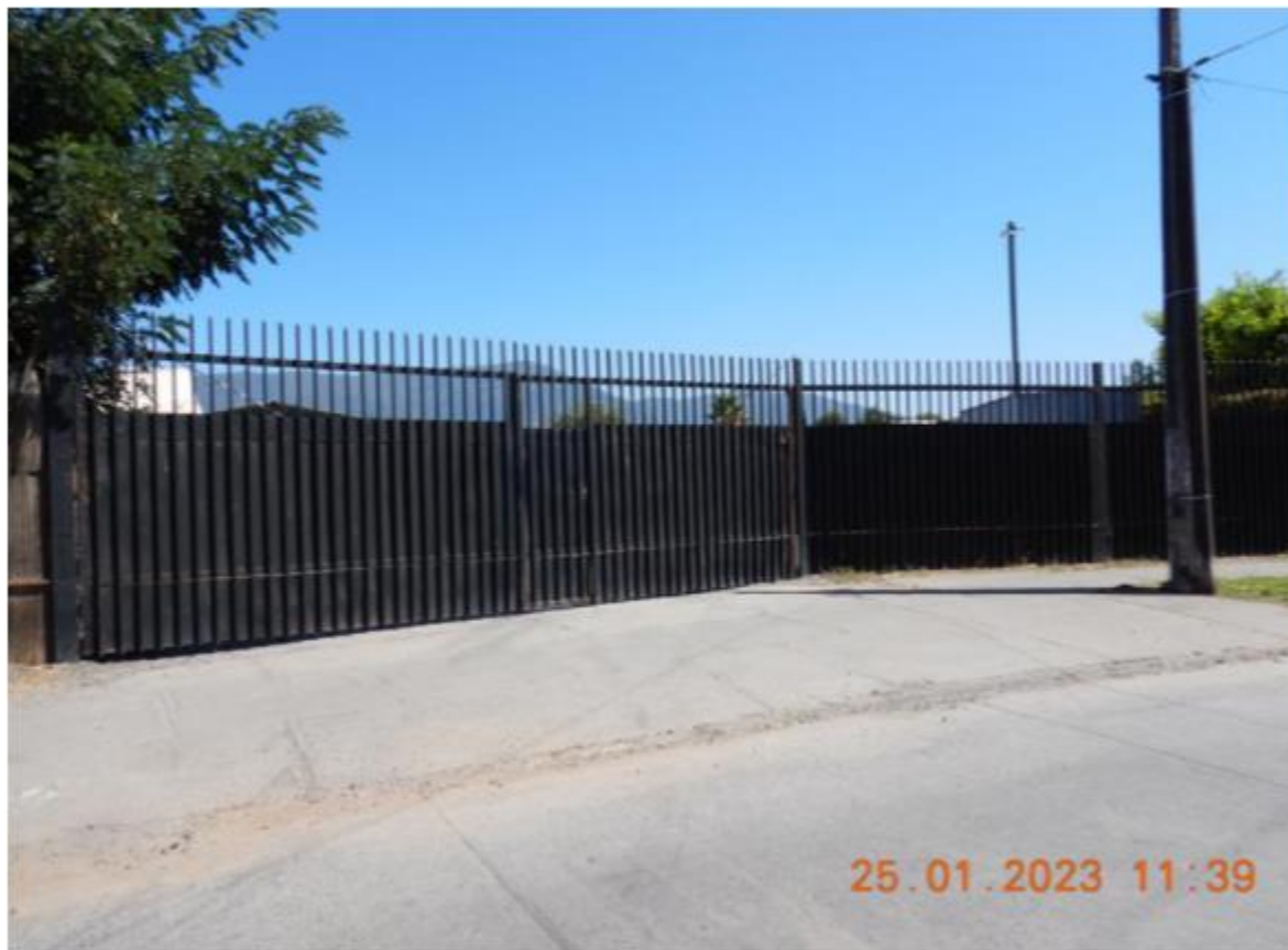
Figura 3. Exterior de Unidad Fiscalizable
