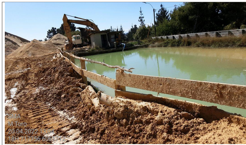
Fotografía 12. Piscina de acumulación y recirculación de aguas.
