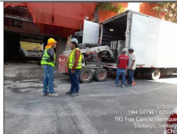
Figura 8. Trabajos con bobcat
