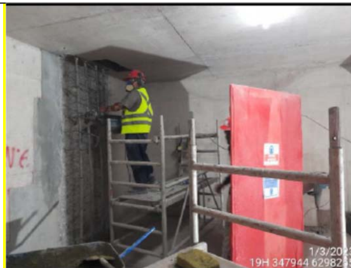
Figura 2. Trabajos con rotomartillo y apantallamiento acústico implementado.
