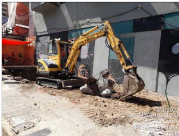
Figura 7. Trabajos con excavadora
