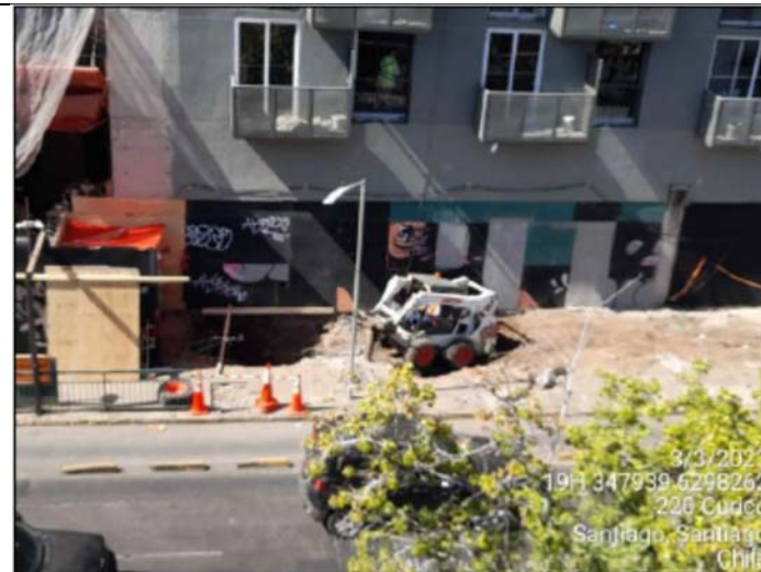
Figura 6. Trabajos con bobcat
