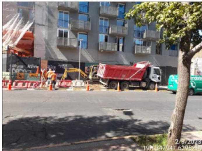
Figura 5. Camión en ralentí y trabajos con excavadora
