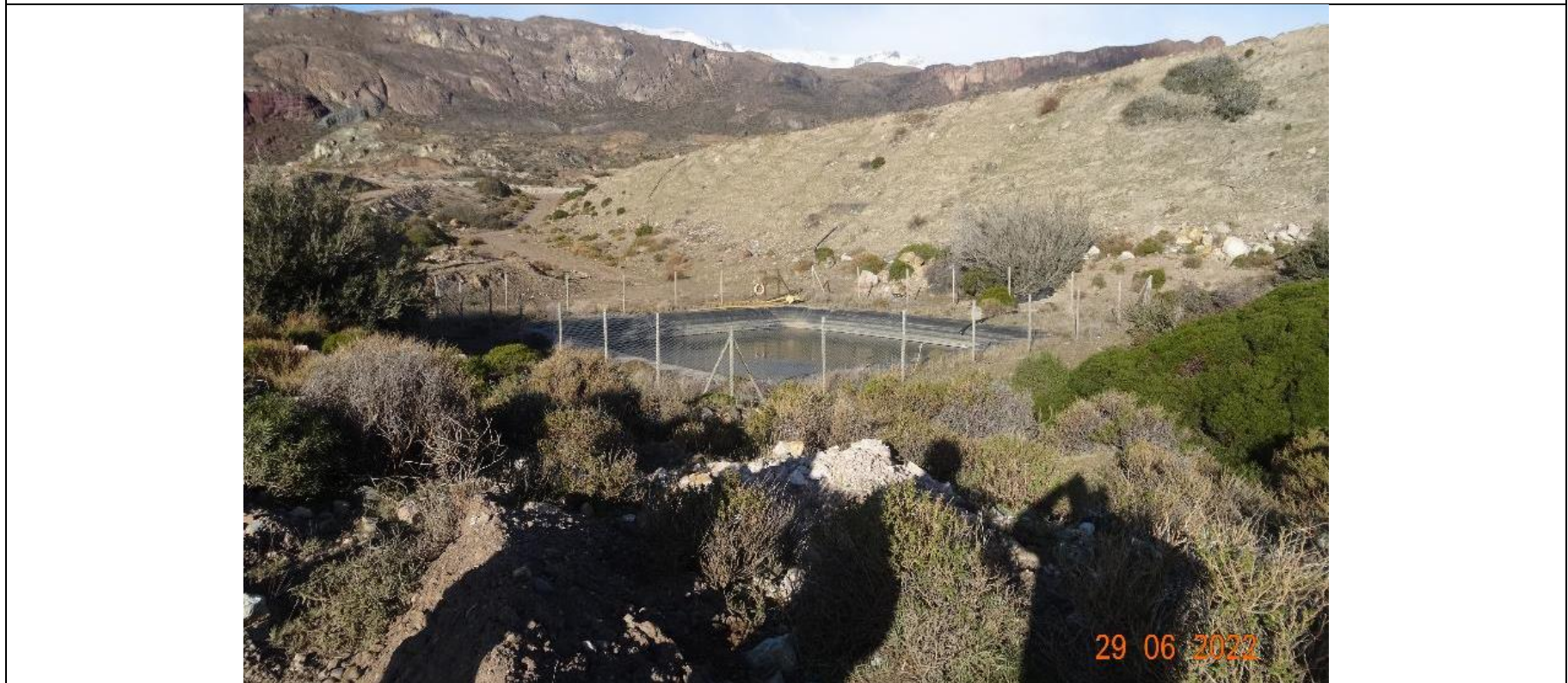
Fotografía 6 Fecha: 29-06-2022 Descripción Medio de Prueba: La piscina que conduce el agua de las tuberías del dren basal se encuentra con líquido y con cierre perimetral en buenas condiciones.
