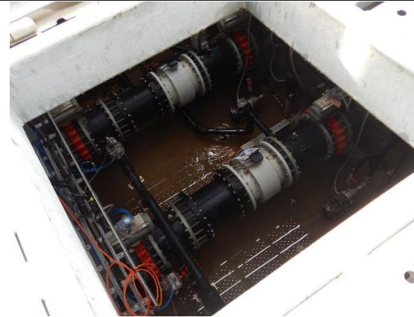
Fotografía 14. Fecha: 01/09/22 Coordenadas UTM DATUM WGS84 HUSO 18 Norte: 4.263.865 Este: 673.459 Descripción del medio de prueba: Vista de flujómetros y equipo de desinfección UV integrado en la tubería de descarga del Sistema de tratamiento de RILes Acopio de Peces.
