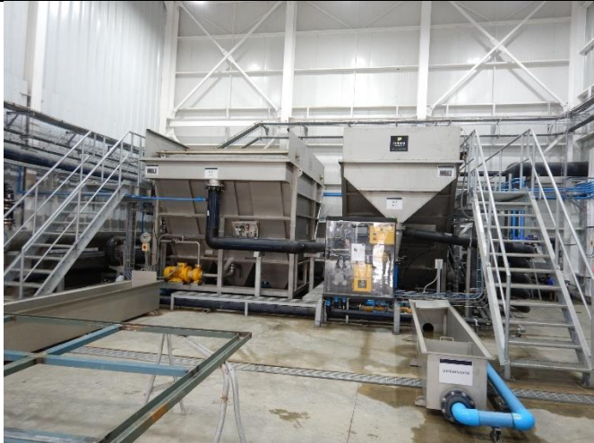
Fotografía 15. Fecha: 01/09/20 Coordenadas UTM DATUM WGS84 HUSO 18 Norte: 4.263.931 Este: 673.662 Descripción del medio de prueba: Vista general de reactores DAF del Sistema de tratamiento de RILES Planta de Proceso.
