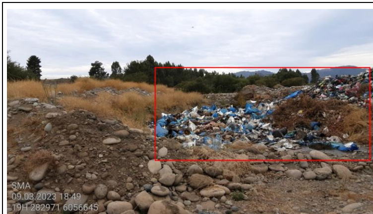
Fotografía 7. Residuos dispuestos fuera del frente de trabajo y fuera del área proyectada para disposición de residuos.
