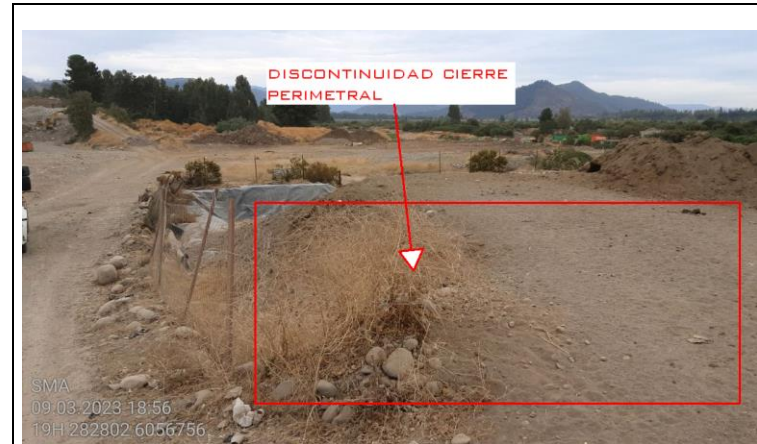
Fotografía 4. Discontinuidad del cierre perimetral de la celda REAS.
