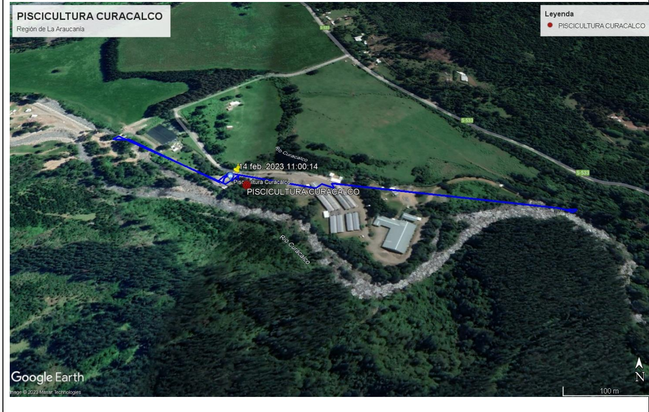
Figura 2. Recorrido realizado durante la inspección de la SMA del día 14 de febrero del 2023 (Fuente: Elaboración propia, Google Earth, 2023).
