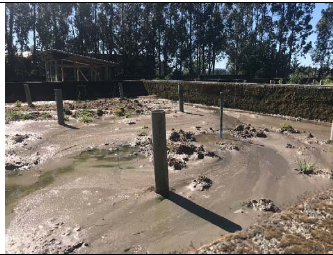
Fotografía N°4: Zona de módulos 1 al 4 con material residual acumulado en superficie generando una cobertura que al secarse a la intemperie libera compuestos odoríferos producto de su descomposición
