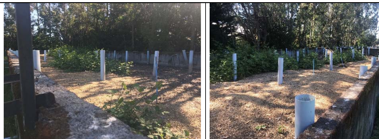
Fotografía N°5 y 6: Módulos 5 y 6 sin operar y con vegetación abundante en zona de lecho filtrante
