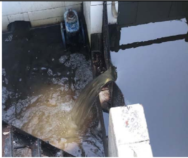
Fotografía N°7 y 8: Cámara de descarga del efluente tratado con presencia de sedimentos en loza previo a su evacuación por ducto de emisario. Efluente se presenta con turbiedad y flóculos en condición de descomposición en base al color negro.
