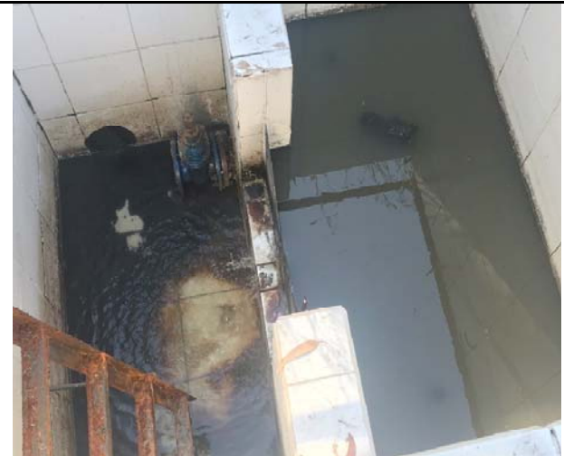
Fotografía N°7 y 8: Cámara de descarga del efluente tratado con presencia de sedimentos en loza previo a su evacuación por ducto de emisario. Efluente se presenta con turbiedad y flóculos en condición de descomposición en base al color negro.
