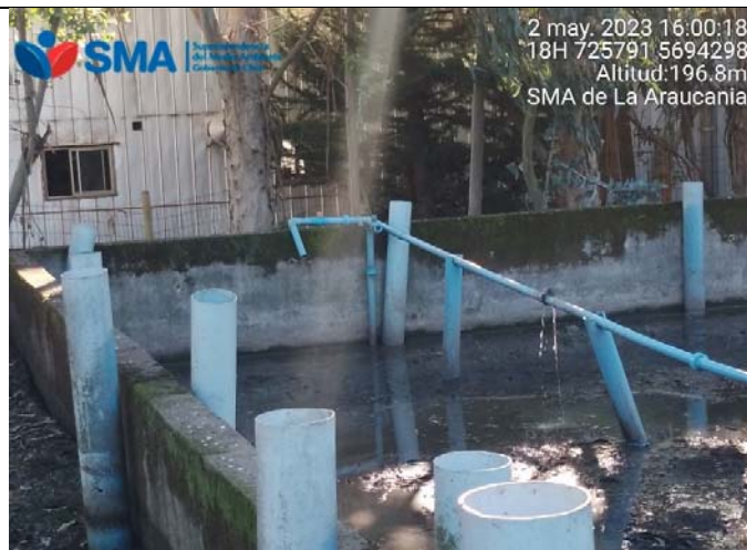
Fotografía N°6: Módulo 2 con apozamiento de aguas que generan deficiencias en la operación del proceso y malos olores por descomposición, considerar la falta de cortina arbórea y distancia respecto a la zona habitada del templo religioso que se ubica junto a este Módulo
