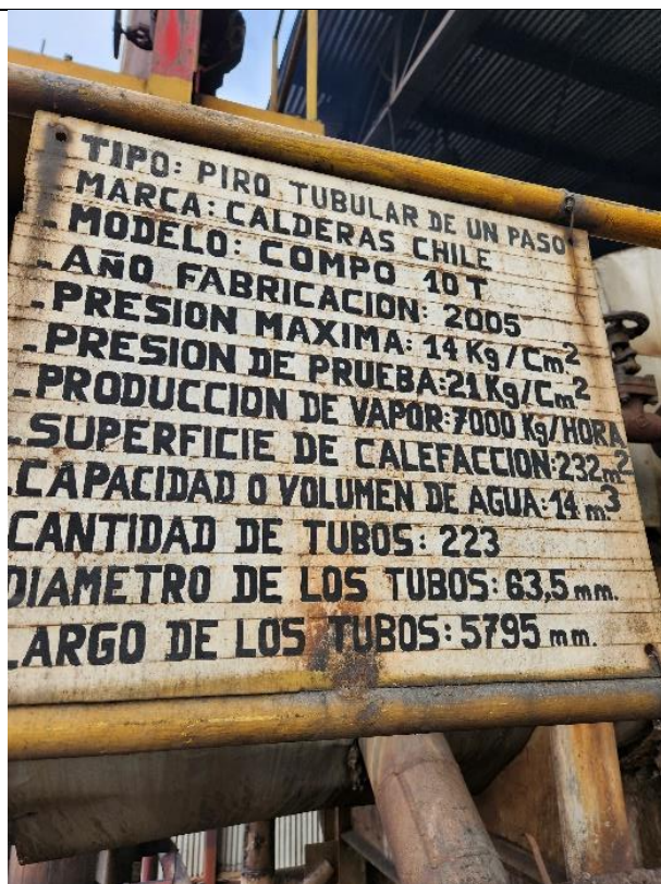
Fotografía 3: Placa caldera en funcionamiento.
