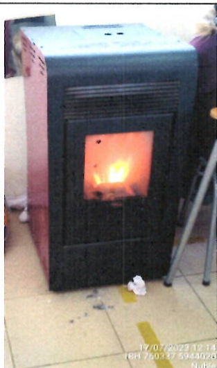
Tercer equipo a pellet habilitado
