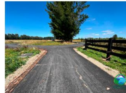
ACCESOS PARCELAS ASFALTADO
