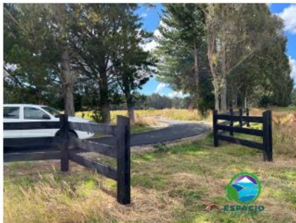
INGRESO PARCELAS ASFALTADO
