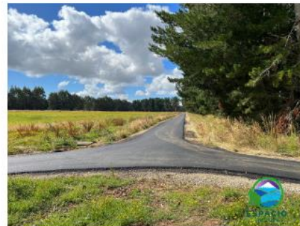
BARRIO PRIVADO ASFALTADO
