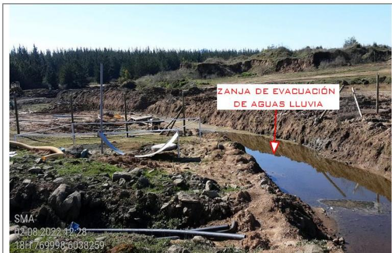
Fotografía 3. Fotografía de la zanja de evacuación de aguas lluvia.
