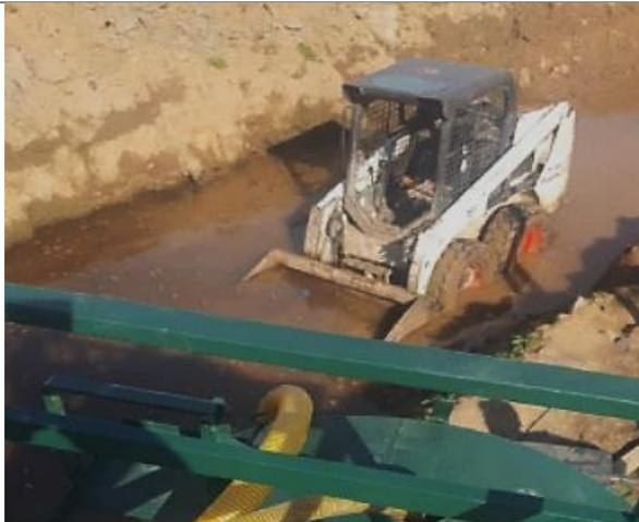
Fotografía 7. Fotografía de la limpieza de zanja de evacuación de aguas lluvia remitida por el titular en informe técnico de agosto de 2022.
