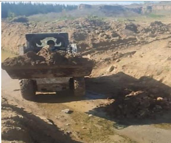
Fotografía 5. Fotografía de la limpieza de zanja de evacuación de aguas lluvia remitida por el titular en informe técnico de agosto de 2022.
