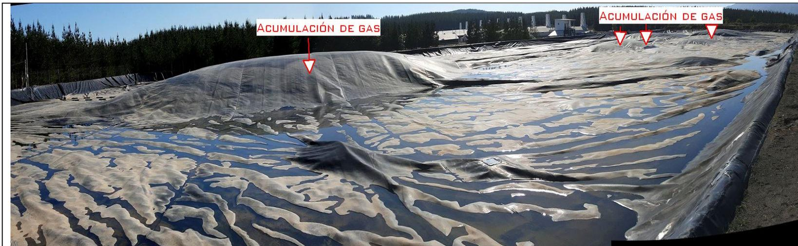
Fotografía 13. Vista en panorámica de la laguna de acumulación de digestato captada en inspección de fecha 02-08-2022. Se indica la acumulación de biogás que genera protuberancias en la cobertura por efecto de la presión en su interior.
