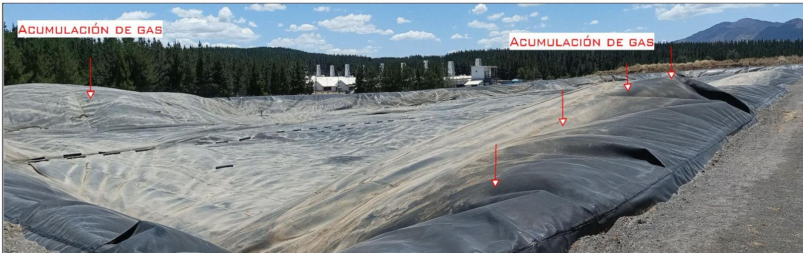
Fotografía 14. Vista en panorámica de la laguna de acumulación de digestato, captada en inspección de fecha 14-12-2022. Se indica la acumulación de biogás que genera protuberancias en la cobertura por efecto de la presión en su interior.
