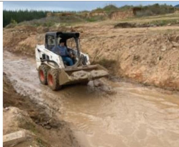
Fotografía 6. Fotografía de la limpieza de zanja de evacuación de aguas lluvia remitida por el titular en informe técnico de agosto de 2022.
