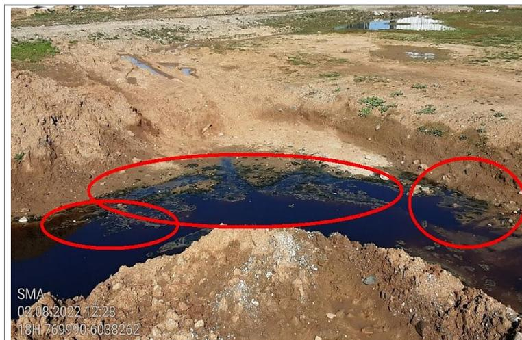
Fotografía 4. Fotografía del líquido de coloración oscura con presencia de algas dentro de la zanja de evacuación de aguas lluvia.
