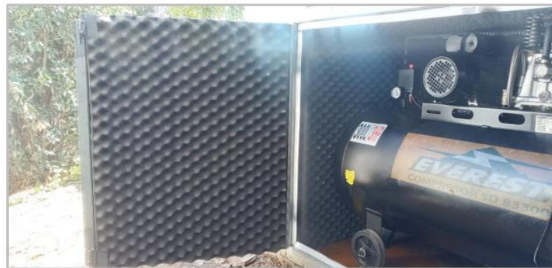
Imagen 4: Implementación de medidas de control en compresores de aire en unidad fiscalizable. Fuente: Reporte cierre de proyecto de instalaciones de medidas de mitigación de ruido estación de servicio ENEX 246 (anexo 4)
