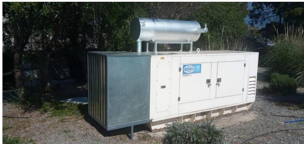
Imagen 2: Implementación de medidas de control en grupo electrógeno en unidad fiscalizable. Fuente: Reporte cierre de proyecto de instalaciones de medidas de mitigación de ruido estación de servicio ENEX 246 (anexo 4)
