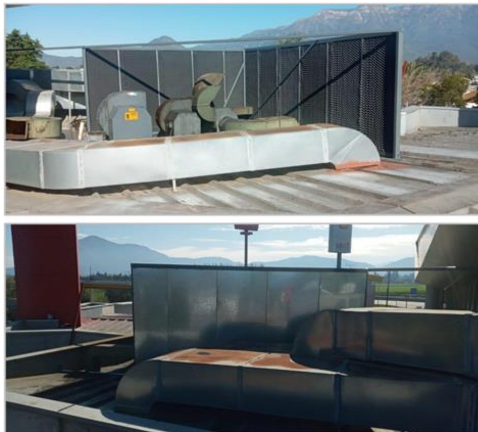
Imagen 3: Implementación de medidas de control en extractores de aire en cubierta restaurant McDonald's. Fuente: Reporte cierre de proyecto de instalaciones de medidas de mitigación de ruido estación de servicio ENEX 246 (anexo 4)
