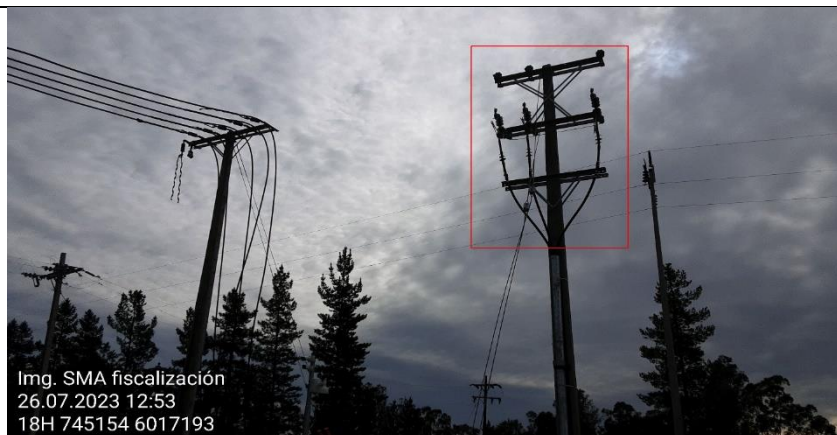
Fotografía 3. Fotografía del poste de salida de energía desde unidad generadora (PFV Cauquenes). Se observa sin conexión activa para la línea de evacuación.
