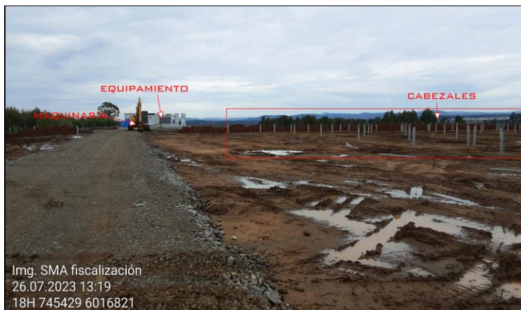
Fotografía 1. Vista general del estado de avance del proyecto PARQUE FOTOVOLTAICO TUTUVÉN. Se observa que se han instalado los cabezales para implementación de paneles solares, obras de equipamiento y maquinaria.
