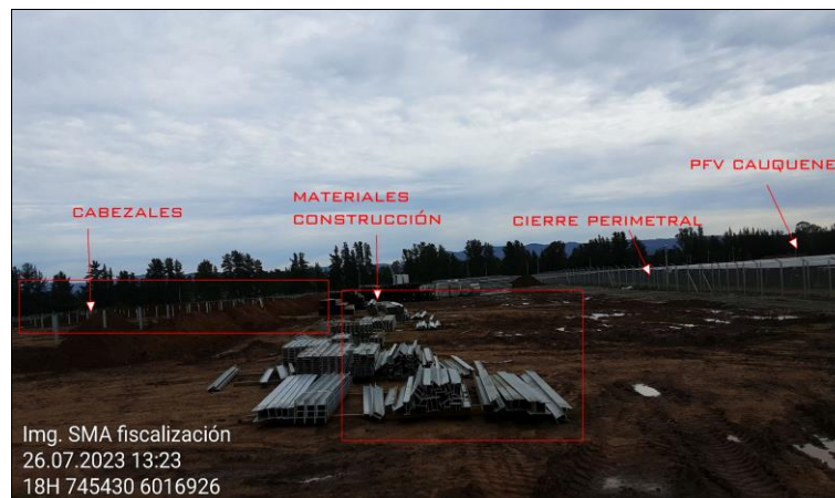
Fotografía 2. Vista general del estado de avance del proyecto PARQUE FOTOVOLTAICO TUTUVÉN. Se observa que se han instalado los cabezales para la implementación de paneles solares y material que da cuenta de la construcción.
