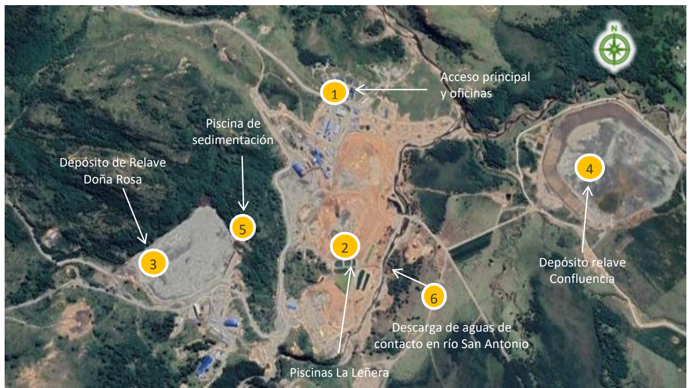
Figura 4. Recorrido de inspección (Fuente: Elaboración propia en base a imagen Google Earth, 2019)
