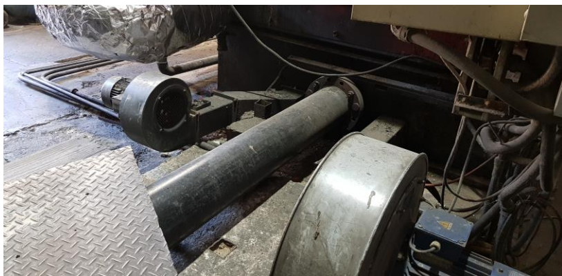
Fotografía 7. Sistema de alimentación de la caldera
