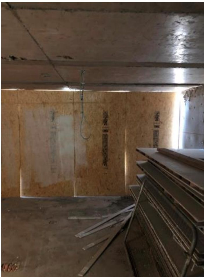
Figura 8: Registro fotográfico de Cierre de vanos Torres I y II
