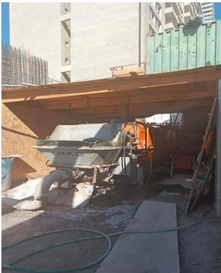
Figura 8. Túnel Acústico para Bomba de Hormigón (26 de marzo de 2024)
