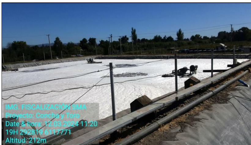
Fotografía 5. Sistema de pre-aireación y ecualización.
