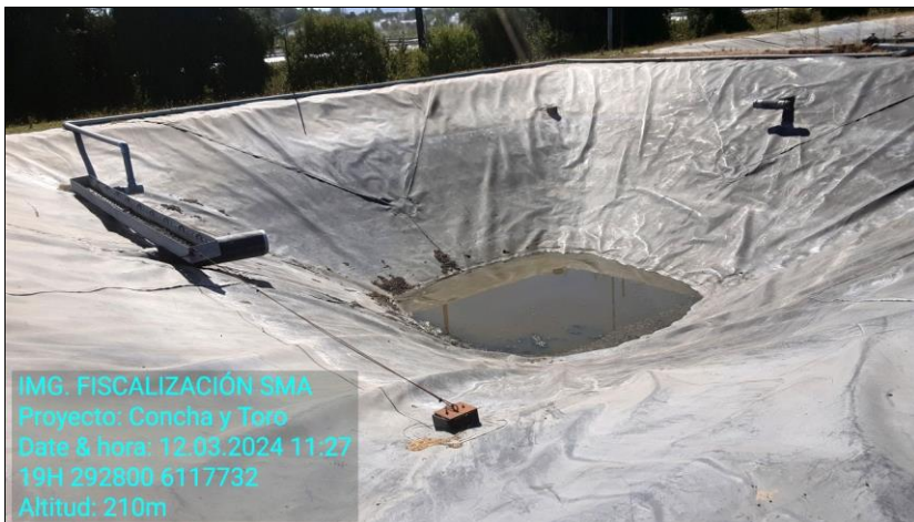
Fotografía 7. Sedimentador fuera de uso.
