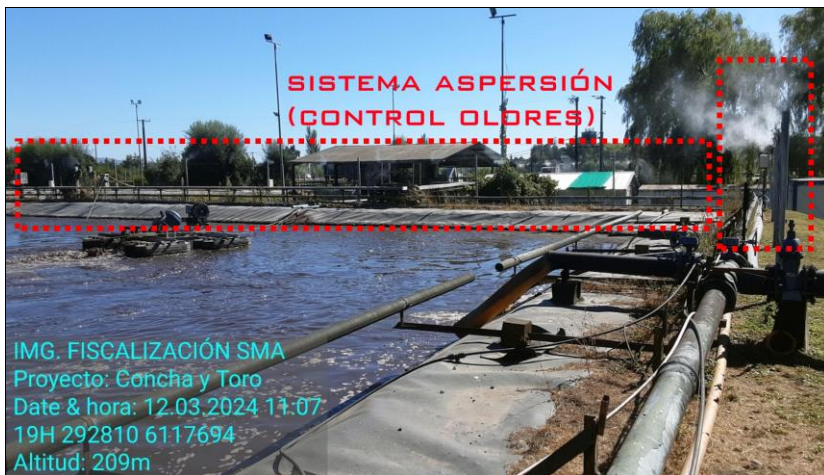
Fotografía 1. Vista general del sistema de aspersión implementada por el titular en la unidad fiscalizable para el control de olores.
