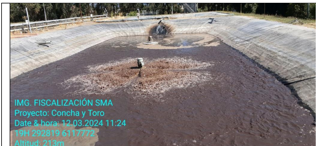
Fotografía 9. Espesador de lodos.
