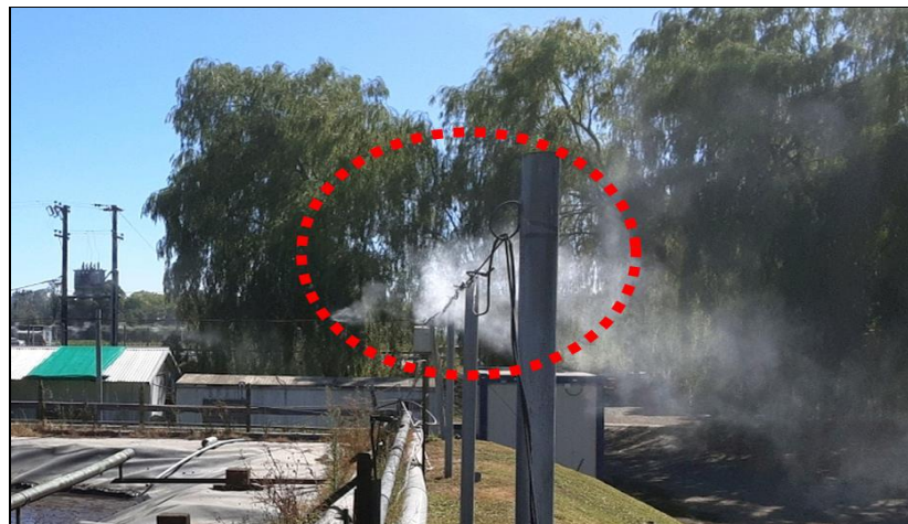
Fotografía 2. Vista en primer plano del sistema de aspersión implementada por el titular en la unidad fiscalizable para el control de olores.
