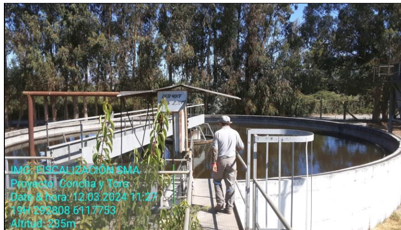
Fotografía 8. Sedimentador en uso.
