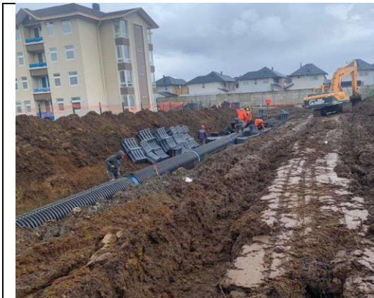
Imagen N°12: Fotografía de la construcción del proyecto de AALL. Fuente: Pocuro Sur.
