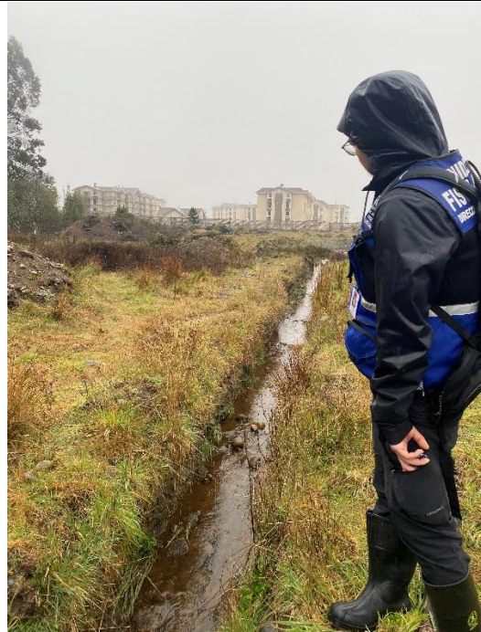
Imagen N°2: Zanja de aguas lluvias en lote 3-b-1, que conecta al estero La Paloma. Fecha: : 22.09.2023
