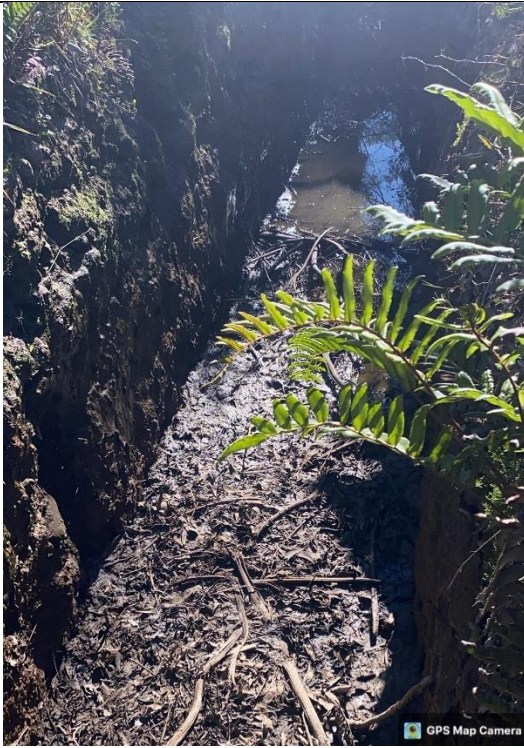
Imagen N°9: Zanjas de evacuación de aguas lluvias que llega el estero la paloma. Fecha:30.01.2024
