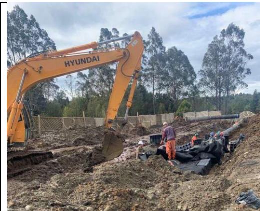
Imagen N°13: Fotografía de la construcción del proyecto de AALL. Fuente: Pocuro Sur.
